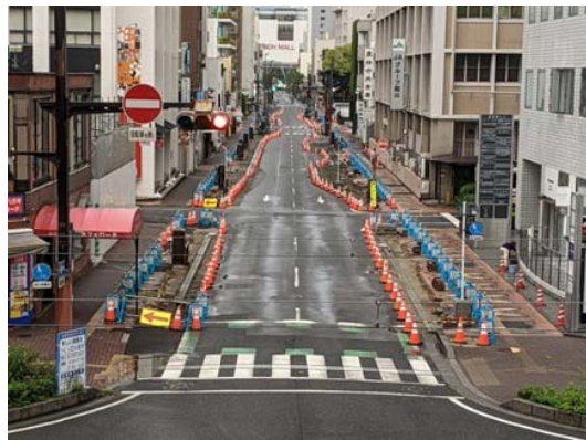
写真-20 岡山駅前イオン 一車線化道路
