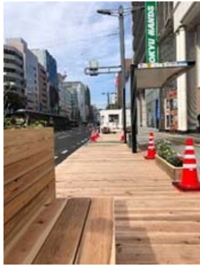
写真-2 車道上に設置したウッドデッキ
