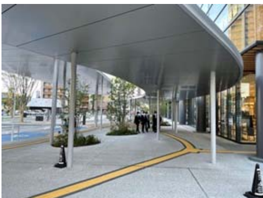
写真-17 JR熊本駅白川口の屋根付き歩道
