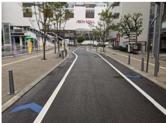
写真-19 岡山県庁通りの一車線化
